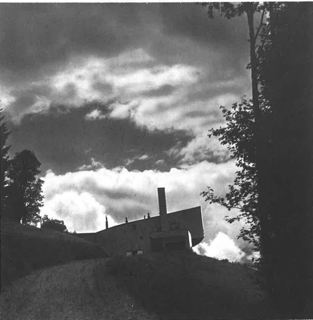
183 Ansicht von Norden, Eingang
