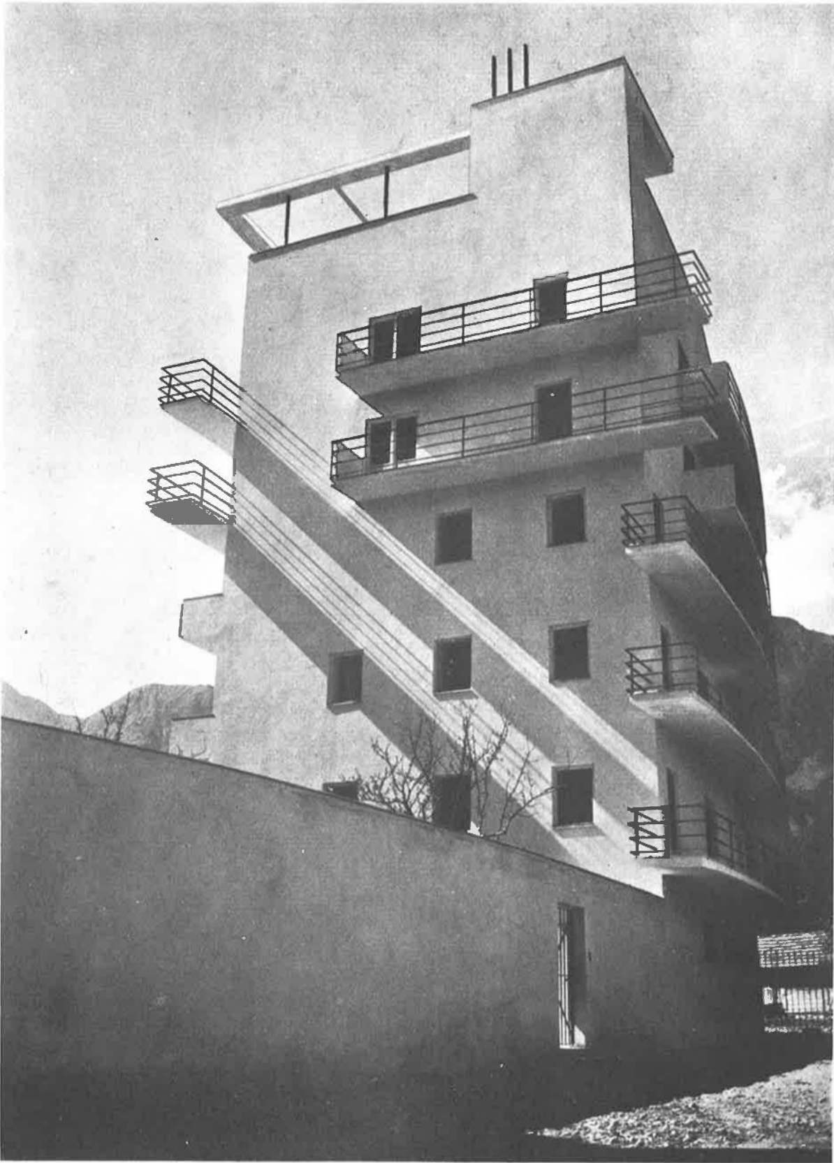
123 Teilansicht von Nord-Osten
