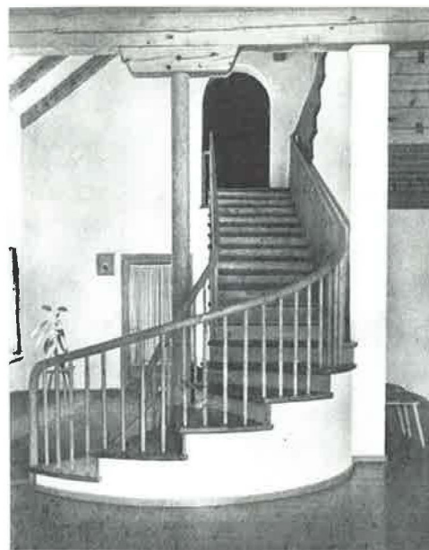
249 Stiege von der Halle ins Dachgeschoß
