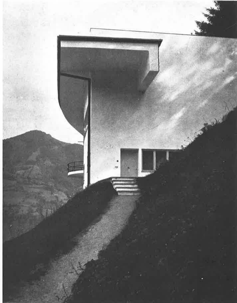
89 Ansicht von Norden, Eingang
