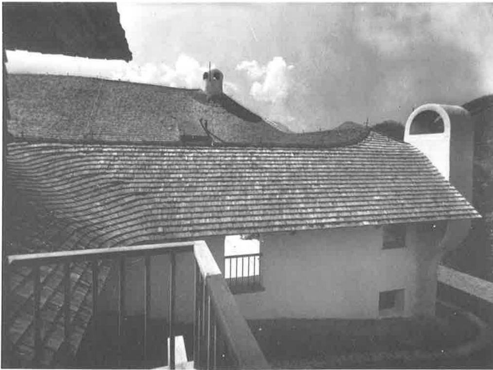
265 Teilansicht von Nord-Osten
